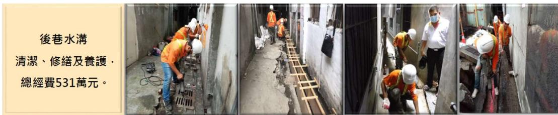
圖十九 後巷排水溝修繕工程
